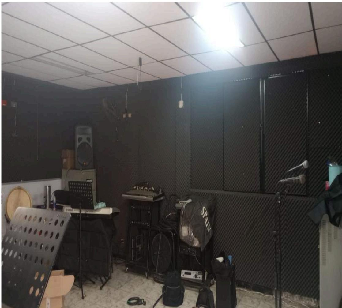
Cielo falso en duracustic y muros en espuma acústica salon de ensayos Música.
